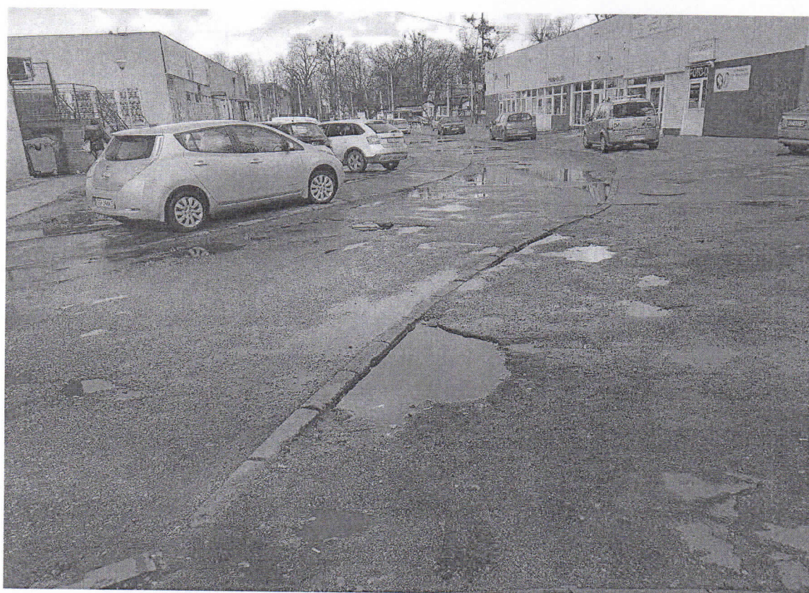
Zdj. nr 3. Widok na chodnik i drogę
